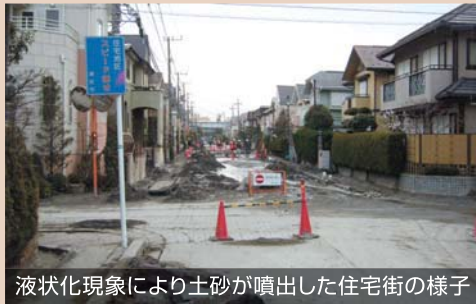
液状化現象により道路が損傷している様子
